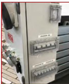
Sicherungen für die einzelnen Steckdosen
